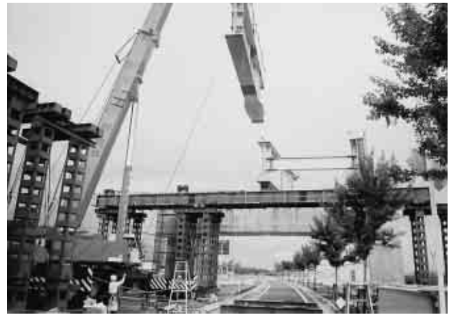
写真 - 4 架設状況
