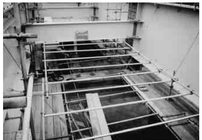
写真 - 5 足場組立状況
